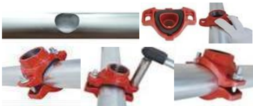
Рис.3. Установка отвода (седелка) под резьбу на трубопровод.
